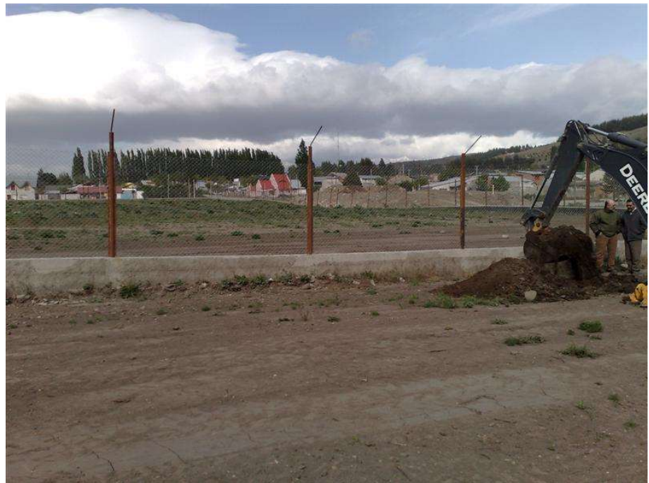
Foto 23. Ejecución Calicata N° 3- Club Belgrano
